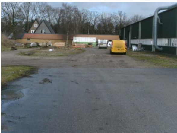
Foto 6: Fundering met recyclinggranulaat (op achtergrond); asfalt op voorzijde hoort bij Rijksweg 39
