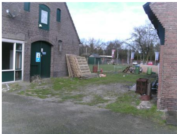
Foto 3: Achterzijde woning en schuur
