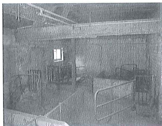
Foto 2: te slopen voormalige varkensstal
