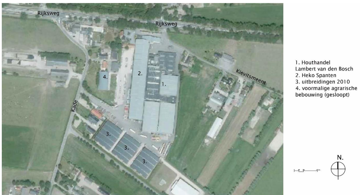
Luchtfoto locatie Rijksweg 39 en Kade 1-3
