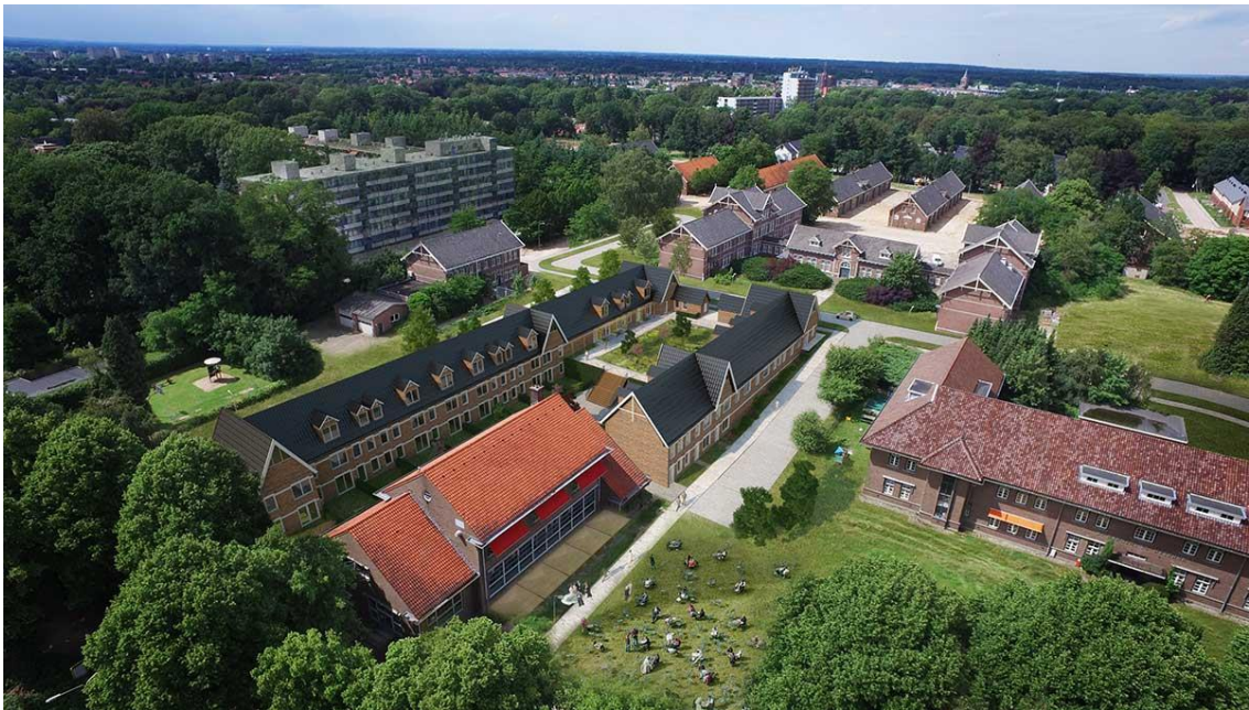
Het bouwveld Maurits Noord 8 (met een impressie van de nieuwbouw)
