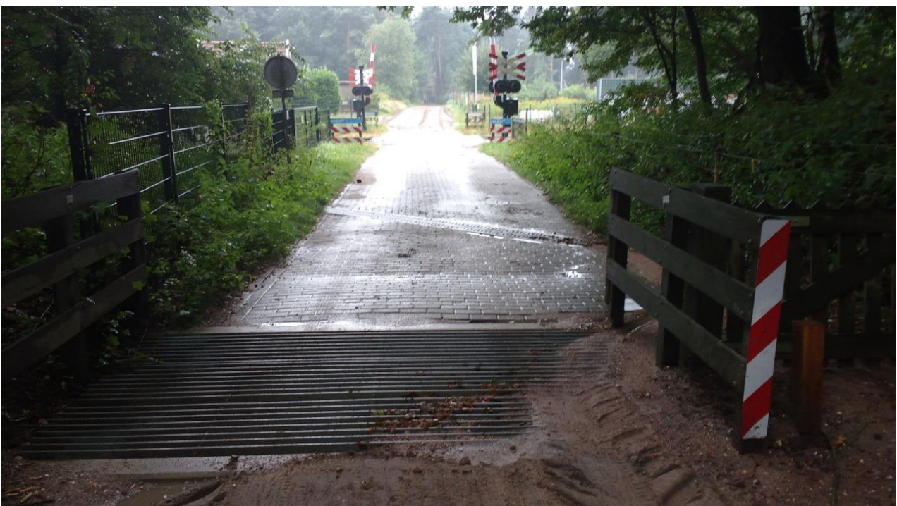
Figuur 4 Spoorovergang Sysselt gezien vanuit het noorden
