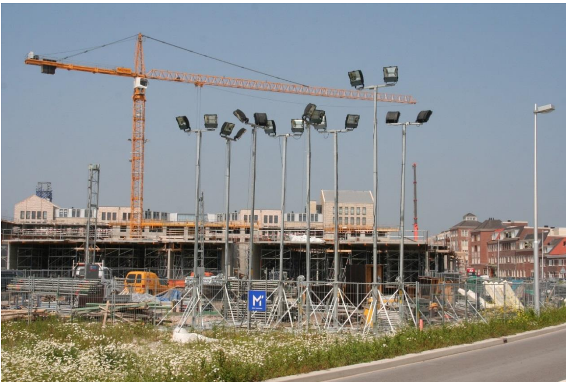
Afbeelding 20 Bouwverlichting op een bouwplaats
