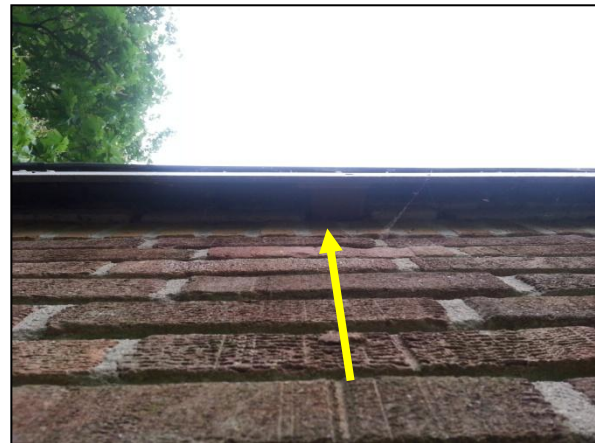
Figuur 19. Ruimte onder dakrand, potentiële verblijfplaats vleermuizen.
