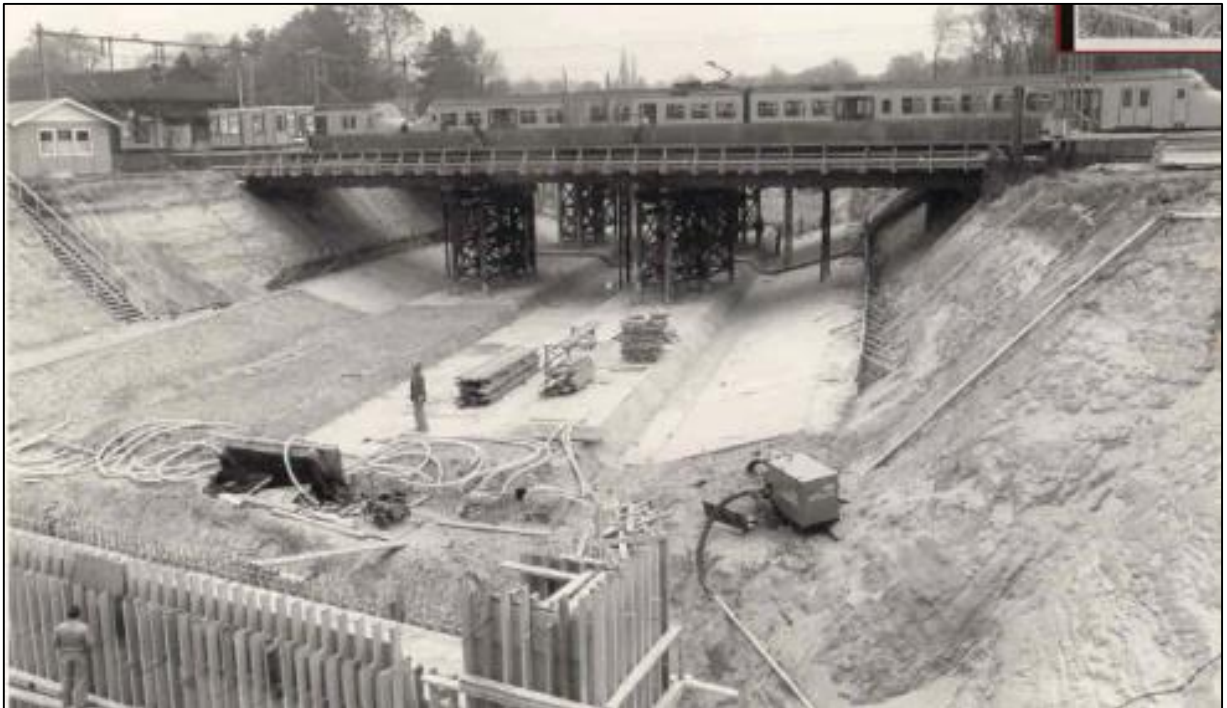
Figuur 19: Bouw Albertstunnel / aanleg Klinkenbergerweg 15
