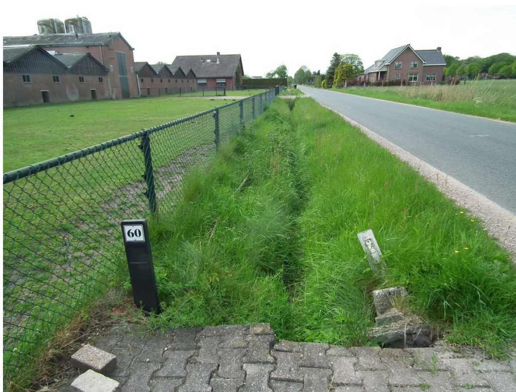
Figuur 2 Lintbebouwing langs de Buurtweg. Links de te slopen schuur "I" (zieFiguur 2, rapport) die voorheen in gebruik was als stal voor de kalveren.
