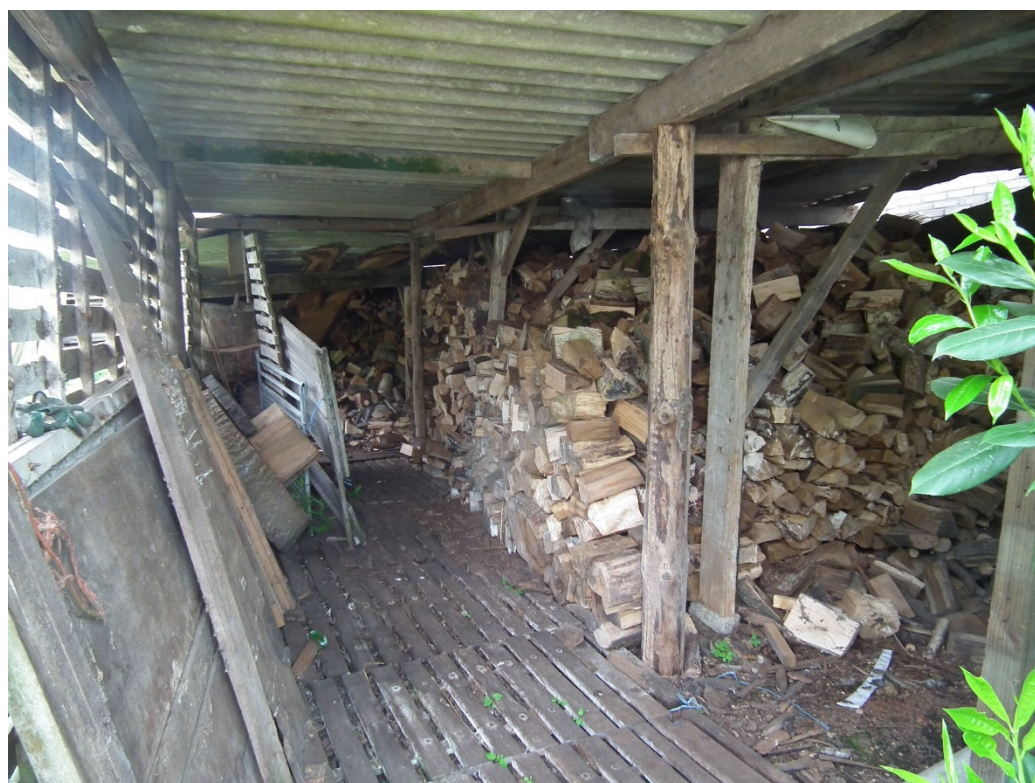
Figuur 12 Houtopslag in schoor "D".
