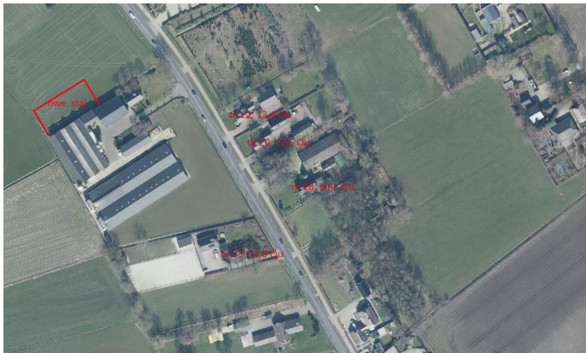
Luchtfoto met geurbelasting
