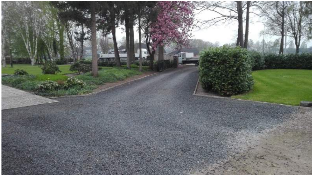
Overzicht inrit (nieuwe verharding)
