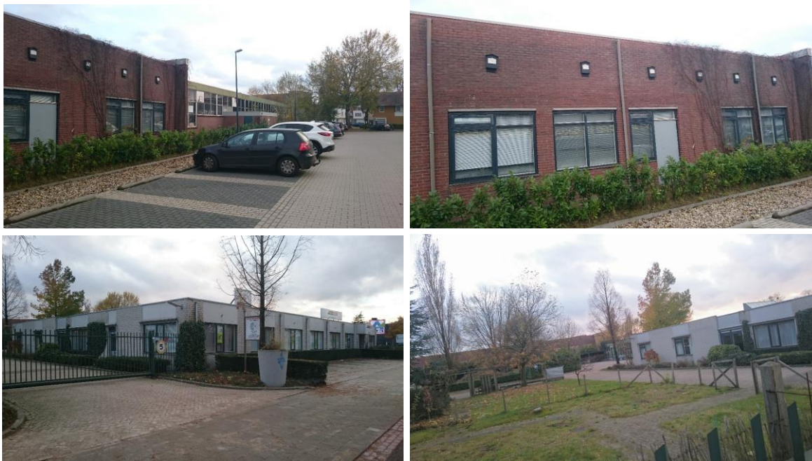
Indrukken van het plangebied (foto's: Laneco) ,et boven links de zijde tegen de Aldi, met boven rechts de 6 vleermuiskasten aan het pand. Beneden links de voorzijde, en beneden rechts de zijkant van het pand..
