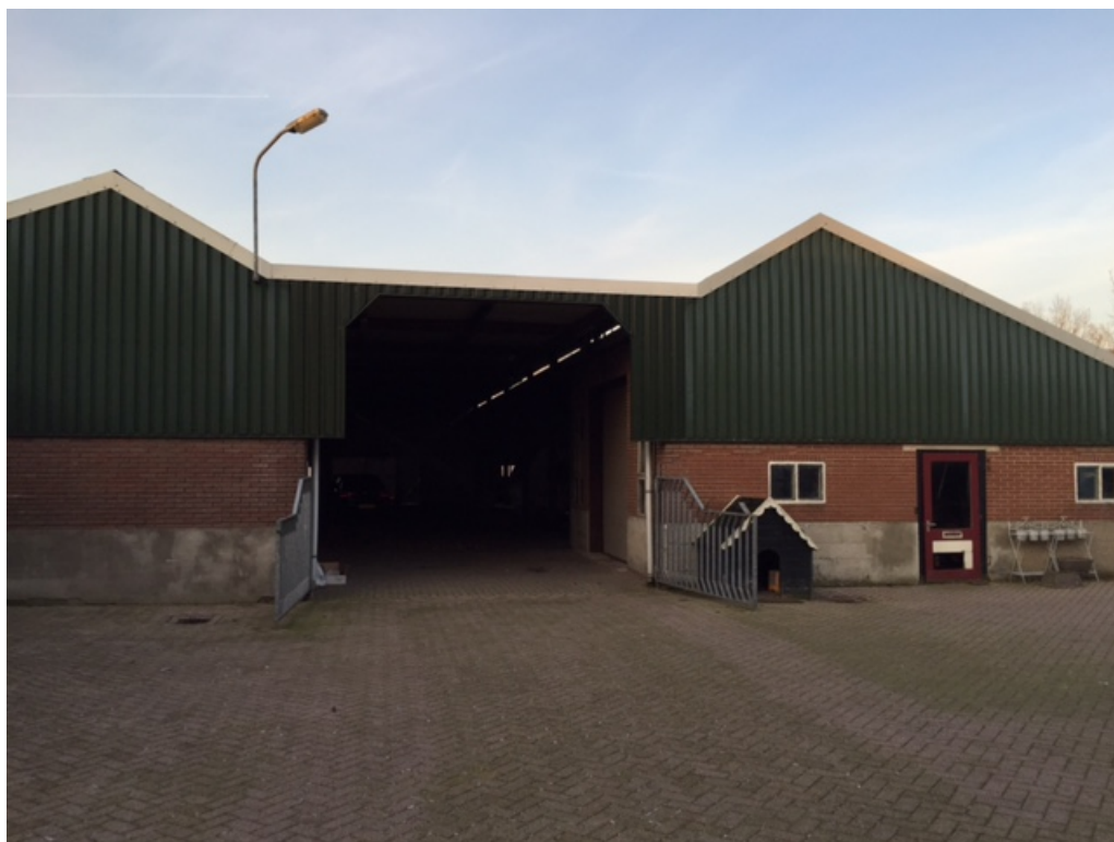
Figuur 1 De te slopen loods is gelegen aan de Braeckweg 20 te Harskamp.
