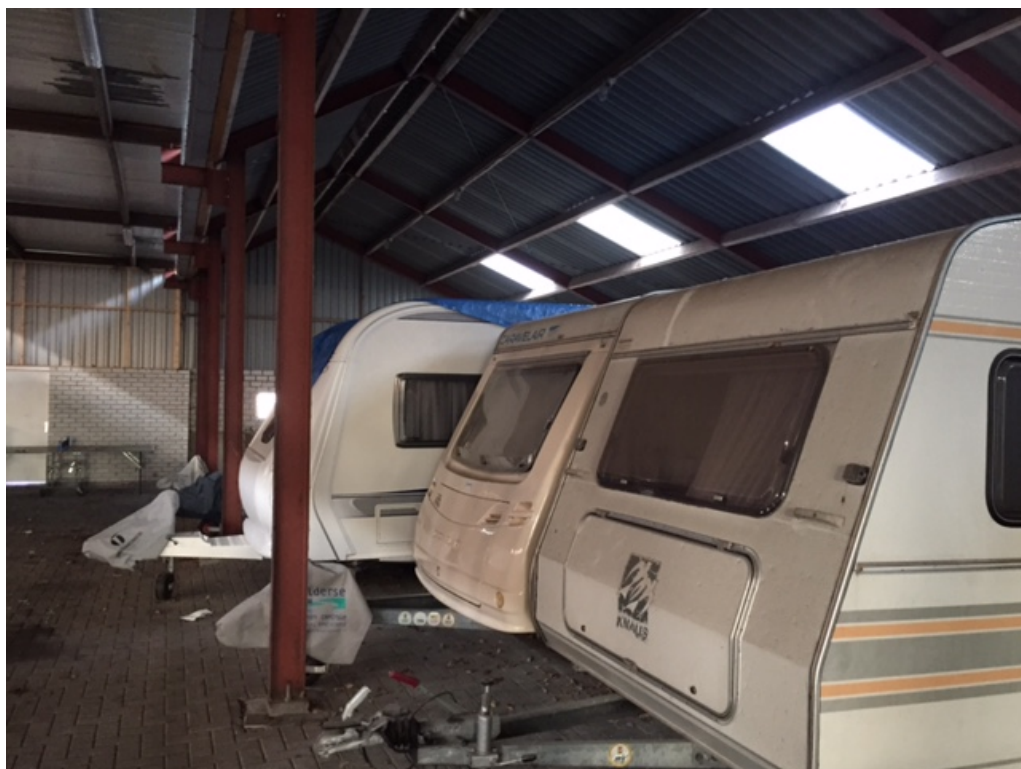
Figuur 2 De loods is momenteel in gebruik als caravanstalling en is zowel van binnen als buiten rondom de loods met name verhard.
