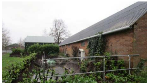
Foto 6: Aanzicht schuur met dakgoot (2)
