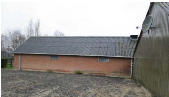
Foto 5: Aanzicht schuur met dakgoot (1)
