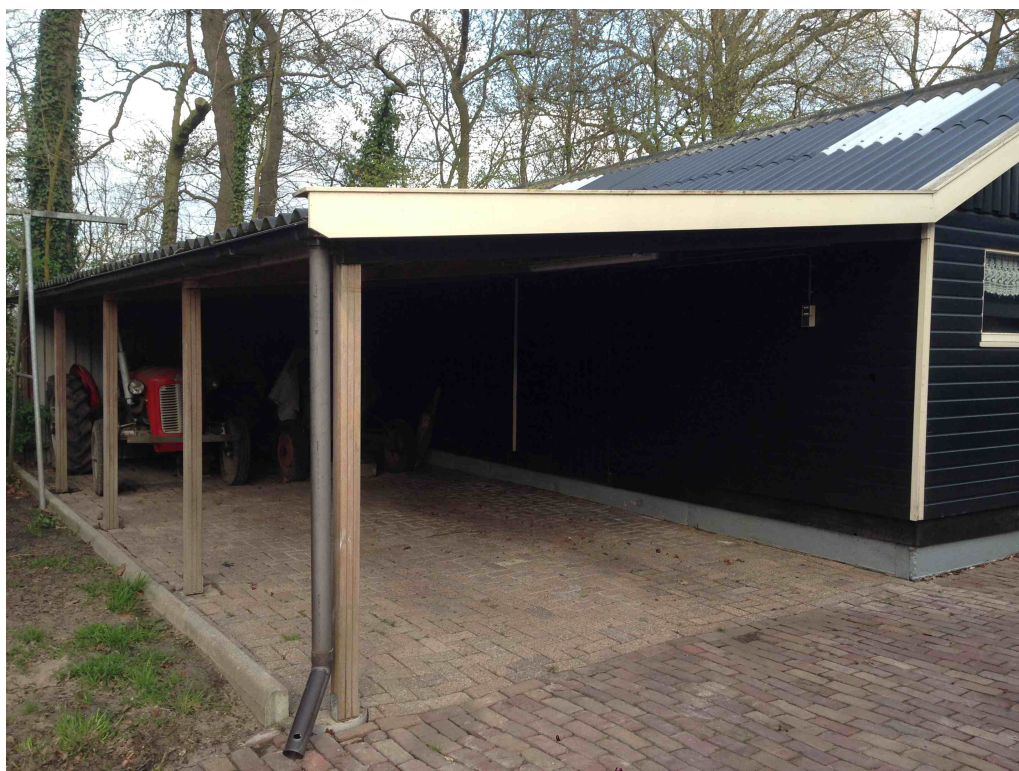
Figuur 3 De carport bestaat uit een houten skelet met een golfplaten dak. Momenteel staan er twee oude tractoren geparkeerd.
