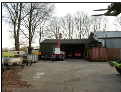
Figuur 6. Kapschuur (te slopen).
