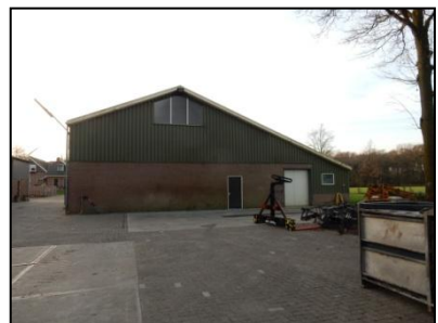
Figuur 5. Loods op westelijk deel (rechterdeel te slopen).
