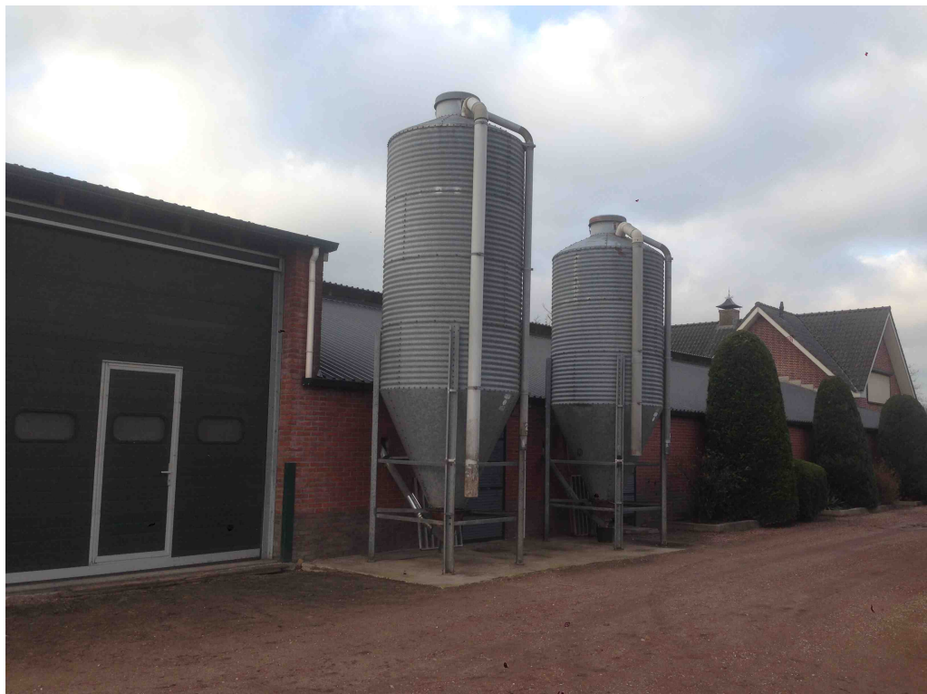
Figuur 2 De varkensstallen bestaan uit steense muren en dak van golf- of damwandplaten.
