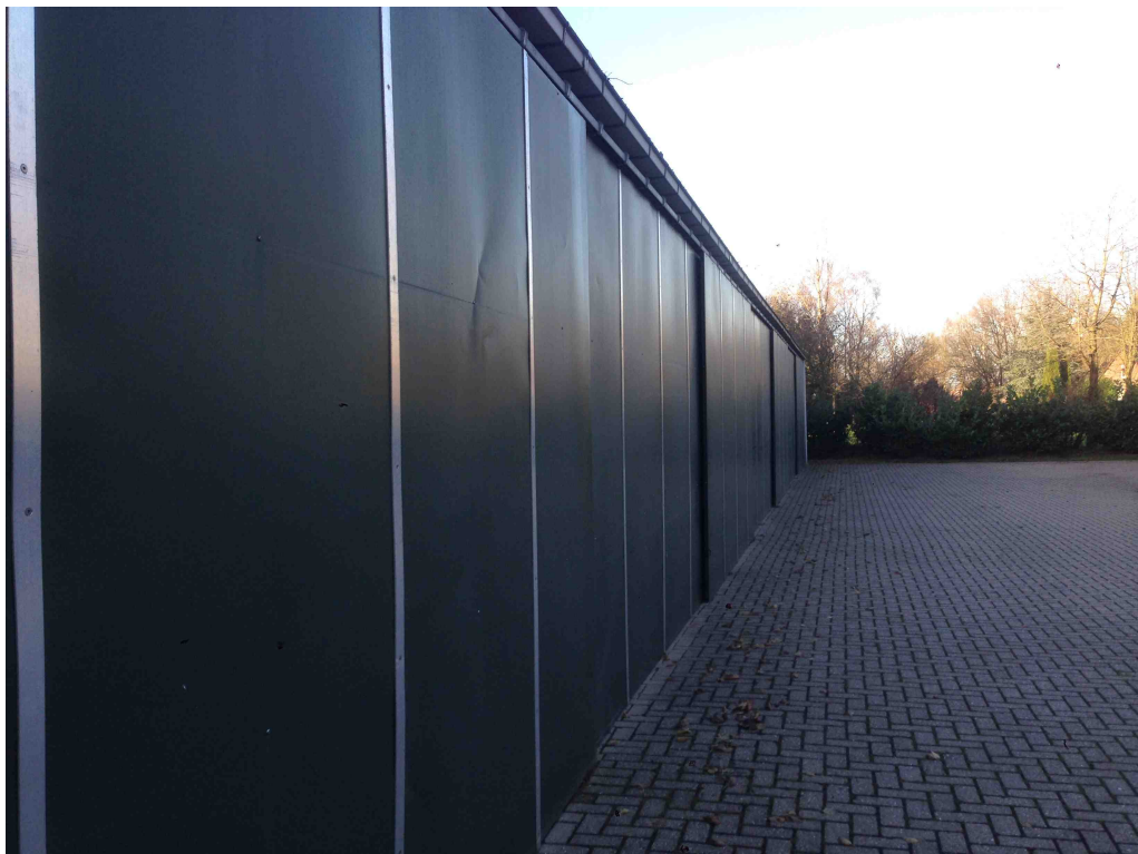
Figuur 3 De grootste te slopen schuur is in gebruik als stalling voor caravans en campers. De schuur heeft een oppervlakte van 905 m 2 .
