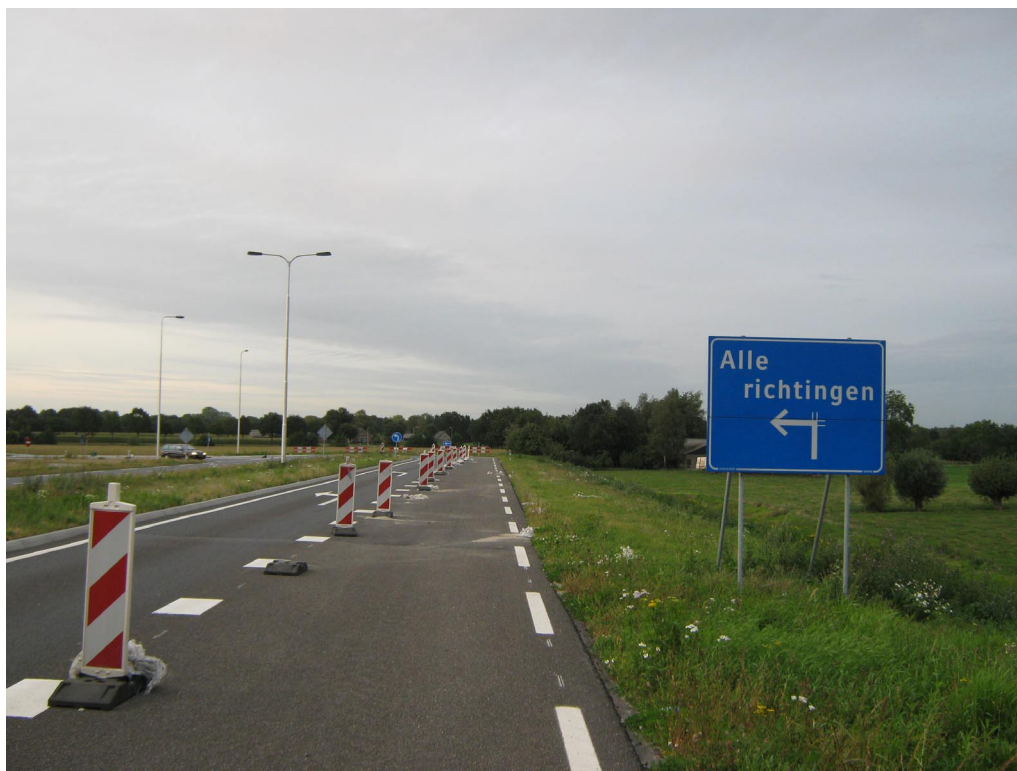
De aan te leggen rondweg De Klomp wordt gerealiseerd door de in 2008 aangelegde rondweg Veenendaal te verlengen.
