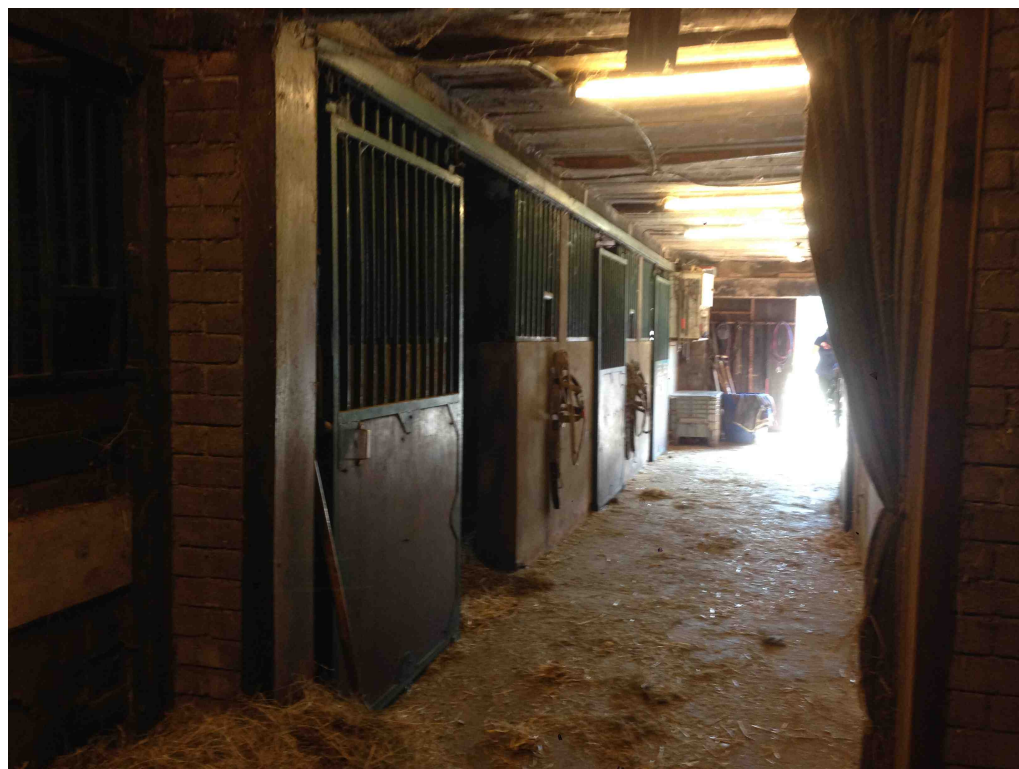
Figuur 4 De schuur achter de woning waar nog enkele paarden gestald staan. De zolder van de schuur is in gebruik als hooiopslag.
