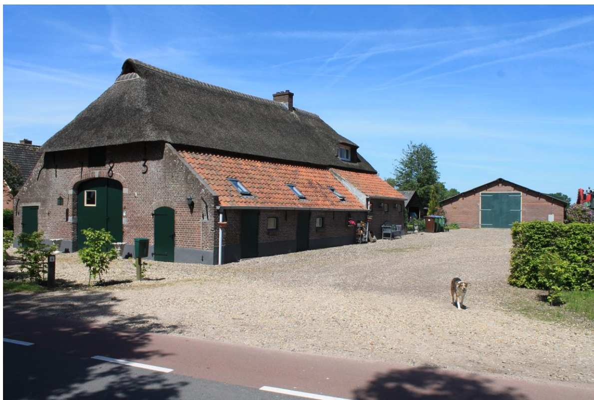
DE BOERDERIJ – DE WONING – EN DE KLEINE SCHUUR (TE SLOPEN) MIDDEN OP HET ERF
