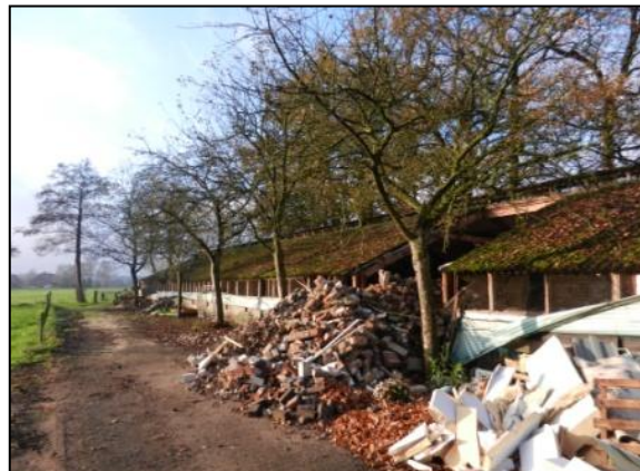
Figuur 8. Schuur 6, deels vervallen schuur.
