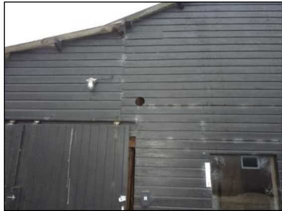
Figuur 6. Schuur 4, Houten stal met centrale zolderruimte.
