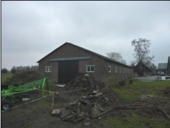
Figuur 3. Schuur 1; voormalige stal, in gebruik voor opslag, voorzien van golfplaten, aan de binnenzijde geïsoleerd.
