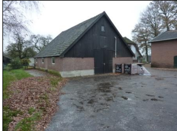
Figuur 4. Schuur 2, voorzien van een pannendak en zolder-ruimte.
