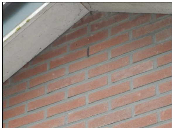
Figuur 11. Open stootvoeg biedt voor vleermuizen toegang tot de spouw.
