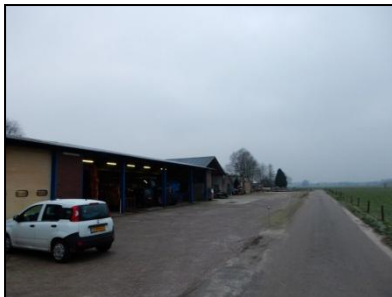
Figuur 3. Overzichtsfoto onderzoekslocatie.
