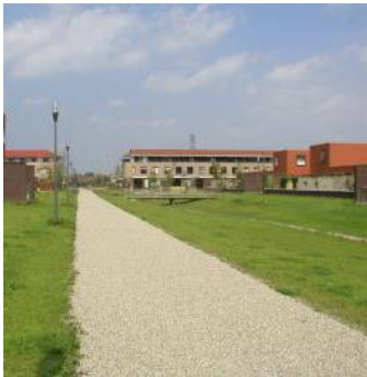
Langzaamverkeerroutes en paden in het centrale groengebied worden uitgevoerd in asfalt met een zandkleurige slijtlaag.
