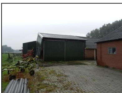
Figuur 6. Kapschuur met damwandplaten.
