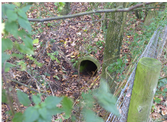
N224-3: Simpele uitvoering faunapassage (rioolbuis beton)
