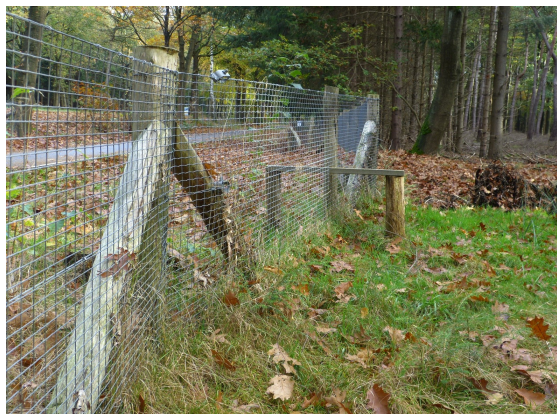
Otterlo 3: Detail hekwerk: 1 meter boven maaiveld; 50 cm ingegraven en 50 cm naar boszijde omgebogen (Apeldoornseweg)
