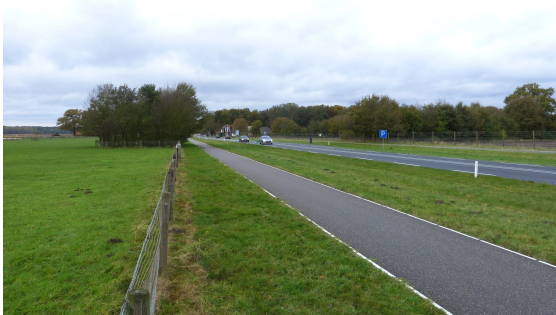
N224-2: Geleiding door hekwerk naar faunapassage in bossage
