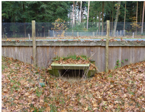
Otterlo 2: Detail "luxe" uitvoering faunapassage (Apeldoornseweg)
