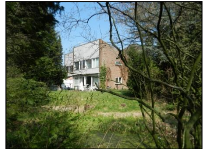
Figuur 8. Bebouwing met tuin en vijver aan noordzijde.
