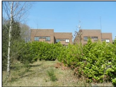
Figuur 7. Te slopen bebouwing aan noordzijde spoorlijn.
