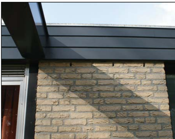
Spouwmuur met open stootvoegen
