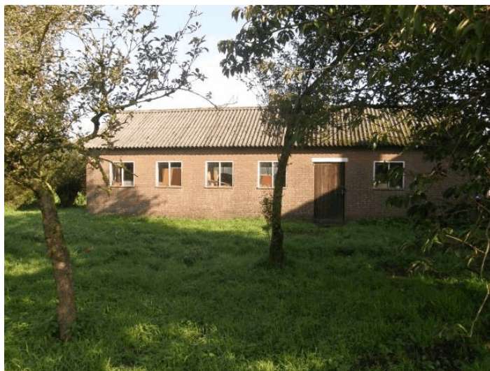
De stenen schuur
