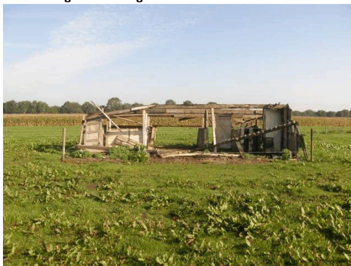
De vanwege asbest afgebroken schuur
