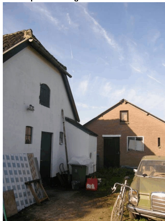
Zicht op de achtergevel en stenen schuur
