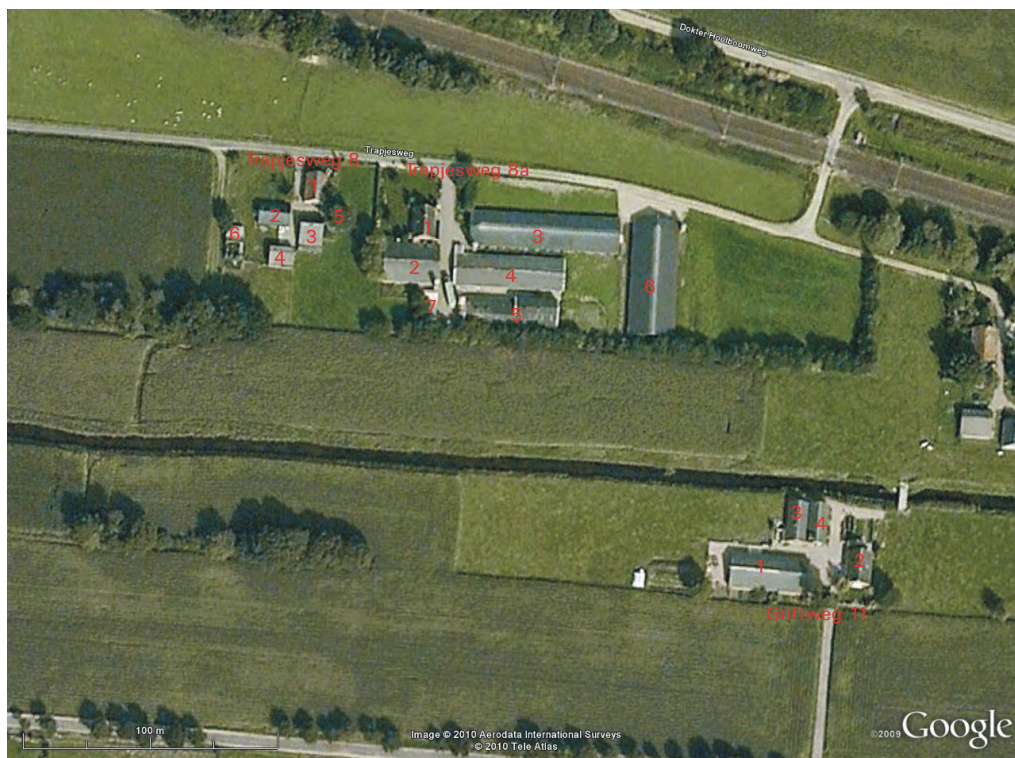
figuur 4. Overzicht van de op korte termijn te slopen gebouwen aan de Griftweg 11 en de Trapjesweg 8 en 8a, in verband met de aanleg van de rondweg.
