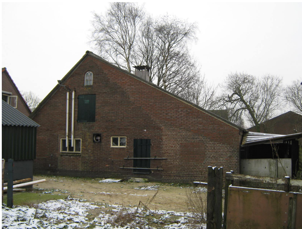
Gebouw 3 aan de Trapjesweg 8 is potentieel geschikt voor vleermuizen.
