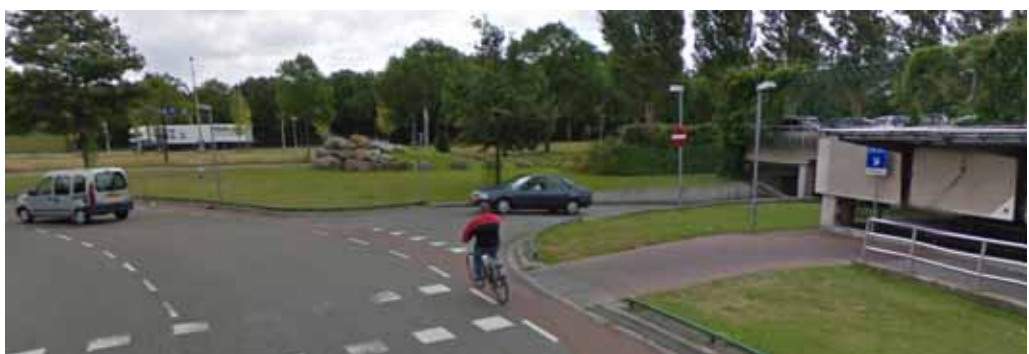
Aanzicht van de uitgang van de parkeergarage
