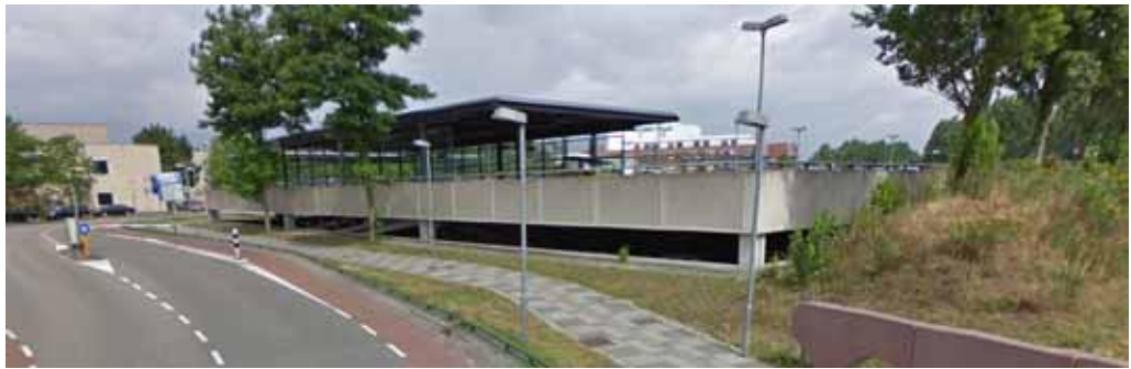
Aanzicht van de parkeergarage
