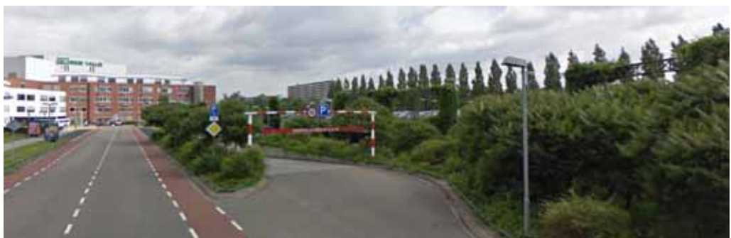
Aanzicht van de ingang van de parkeergarage
