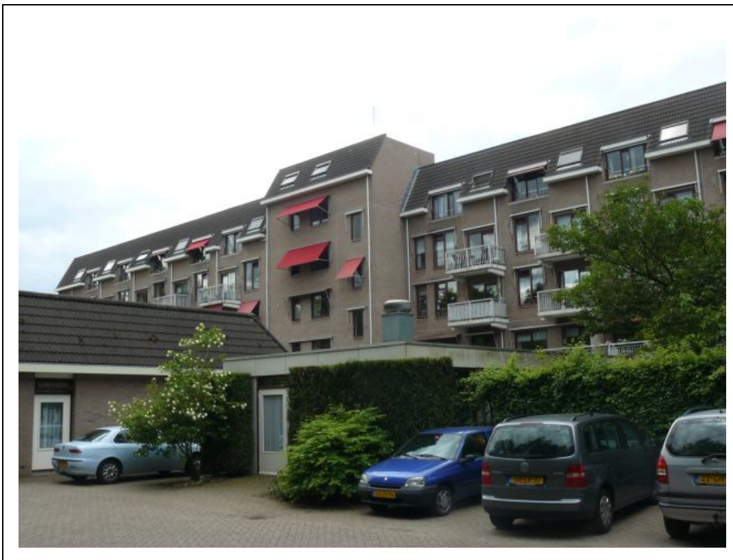
Foto 1. te slopen hoofdgebouw
