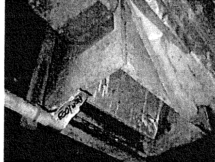
Foto 12: Opstal 7: AC-golflaten op het dak (Abm/007).
