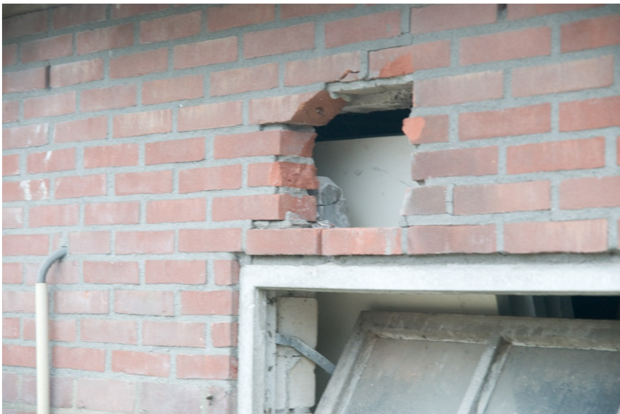
Alle stallen hebben muren die enkelsteens opgetrokken zijn.
