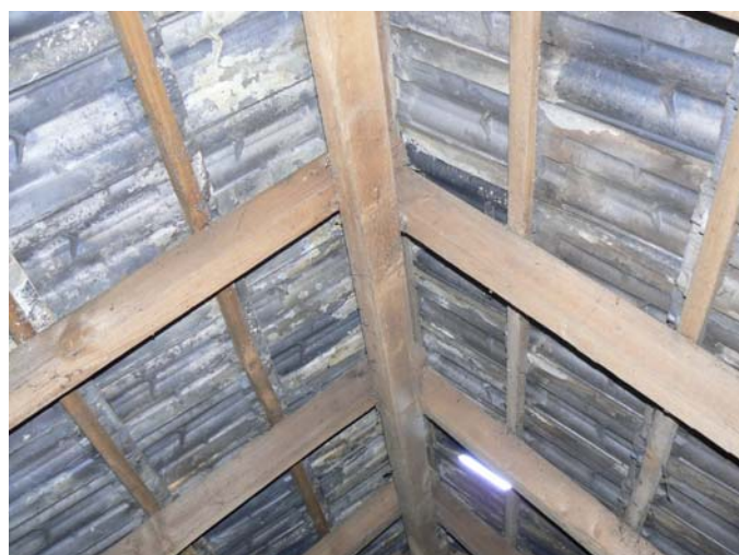
Figuur 6: De zolder van de bestaande woning
