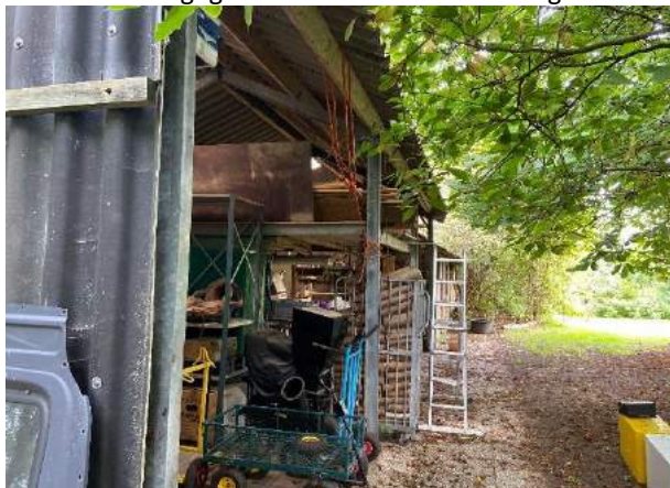
Figuur 13: Overzichtsfoto bebouwing
