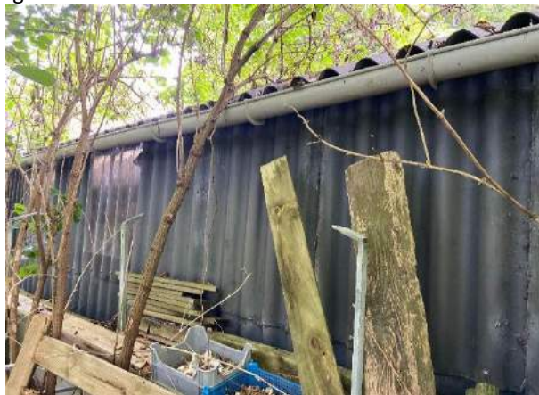
Figuur 14: Dakgoot bebouwing
