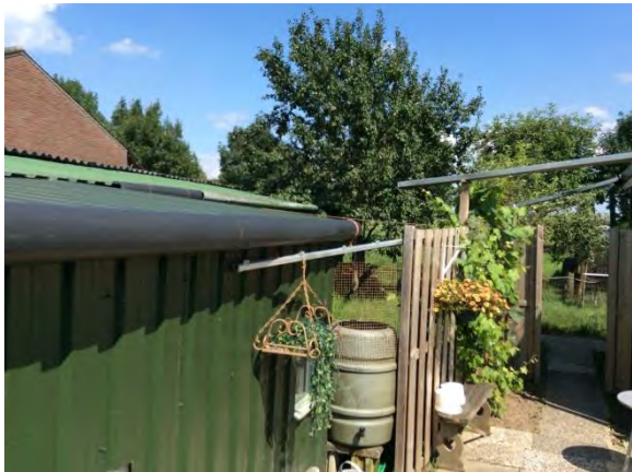
Figuur 11: Dak(goot) bebouwing
