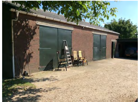
Figuur 12: Dak(goot) bebouwing
