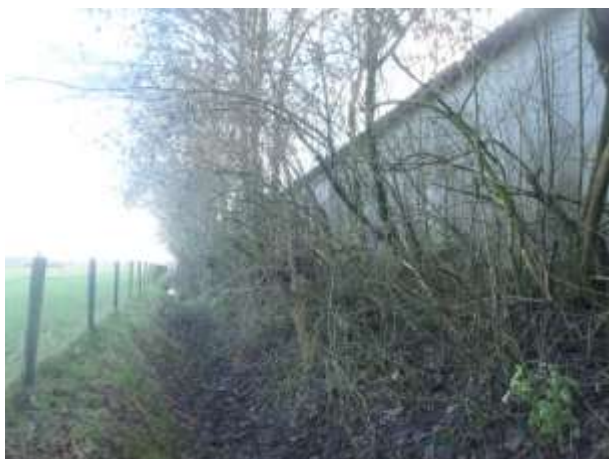
Foto 6: de beplanting aan de noordzijde van de gebouwen 3 t/m 6 naast de deels droge sloot.
