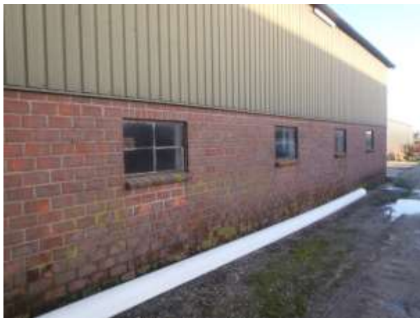
Foto 3: zuidzijde van schuur 7 afbeelding 3. Een deel van de schuur is over een oude gemetselde schuur heen gebouwd. Zoals op de foto is te zien zijn er geen toegangsmogelijkheden voor dieren via de muur. Alles is goed afgedicht.
