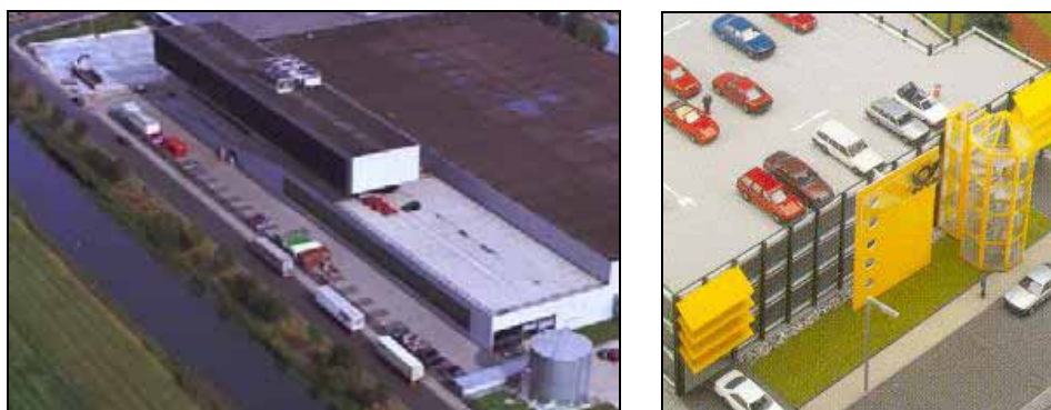
parkeren op het dak van de bebouwing
