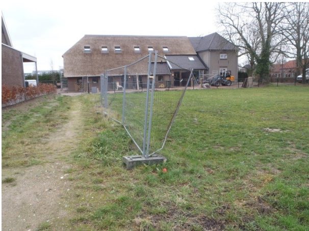
Foto 3: de noordrand van het plangebied met enkele bouwhekken. Links op de foto is nog net de recente nieuwbouw zichtbaar en op de achtergrond de monumentale boerderij.
