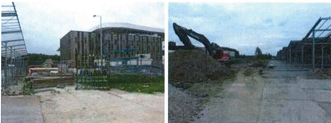
Figuur 2 Foto's van de bouwwerkzaamheden in de directe omgeving.
