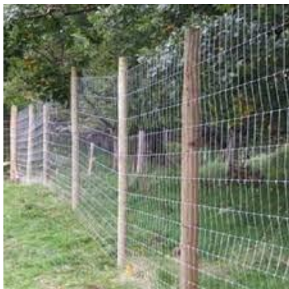
Figuur 4 - Impressiefoto's van landelijk hekwerk bestaande uit ronde houten palen met een grof mazig schapengaas.
