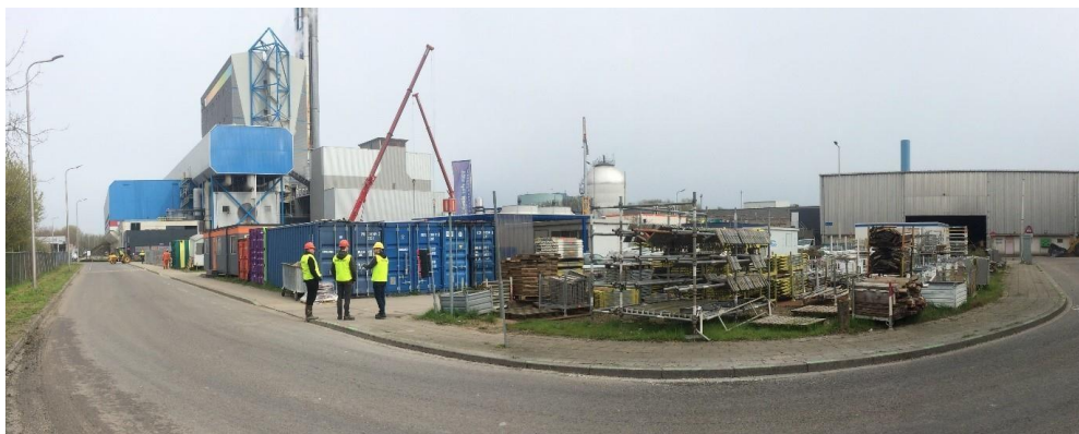
Huidige locatie grootschalige opslag voor contractanten; bouw CO2-afvanginstallatie is reeds gestart.
