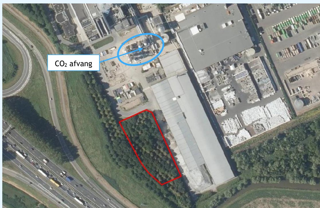
figuur 1: beoogde uitbreiding (rood) en gerealiseerde CO 2 -afvanginstallatie
