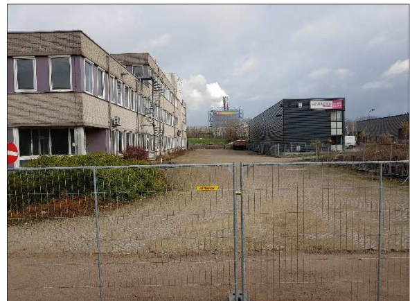
Figuur 4. TNT-post gebouw en loods Cartograaf 12 t/m 12C
