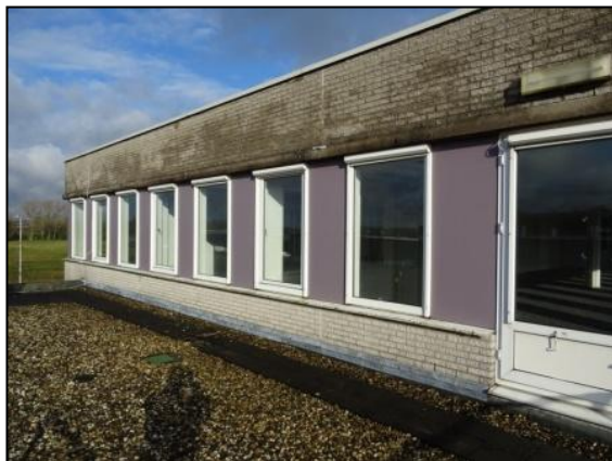
Figuur 5. Zicht op de tweede etage vanaf het dak van de eerste etage.
