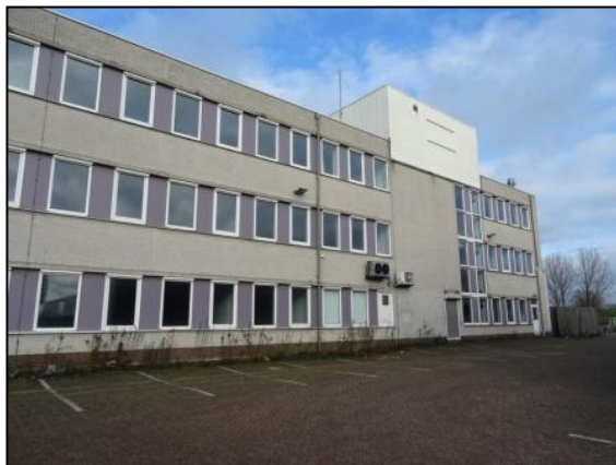
Figuur 3. Zuidzijde van het kantoorgebouw. Het gebouw telt 3 verdiepingen en een opbouw met metalen damwandprofielen.
