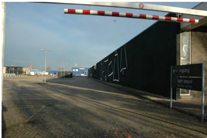
Foto 2: West-aanzicht (Blok 1 en 2)
