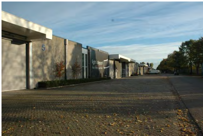
Foto 1: Zuid-aanzicht complex (Blok 2)
