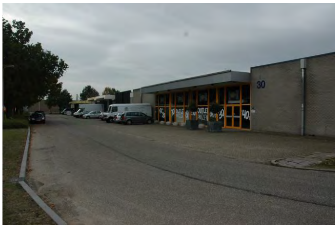
Foto 4: Noordoost-aanzicht complex (Blok 3)
