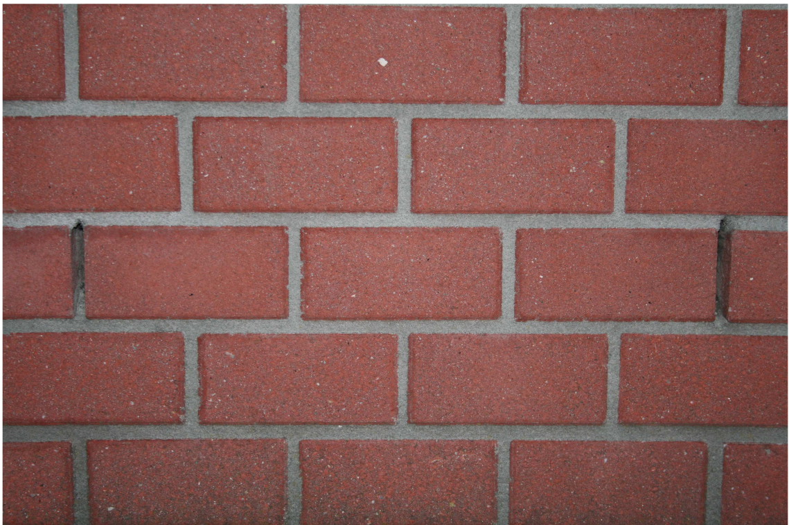
Foto 2 Zicht op de muur van "Slaapgenoten" met aanwezige spouw/stootvoegen
