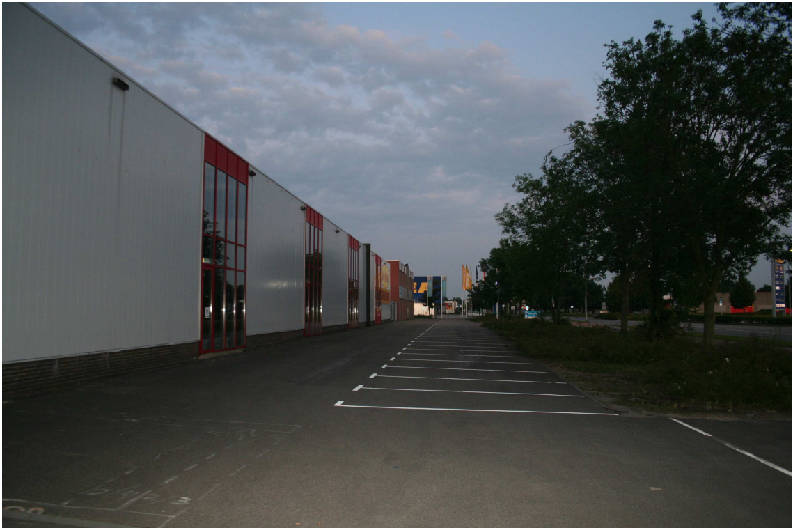
Foto 1 Zicht op het (noord) westelijke deel van de planlocatie: bedrijven terrein met bomensingel
