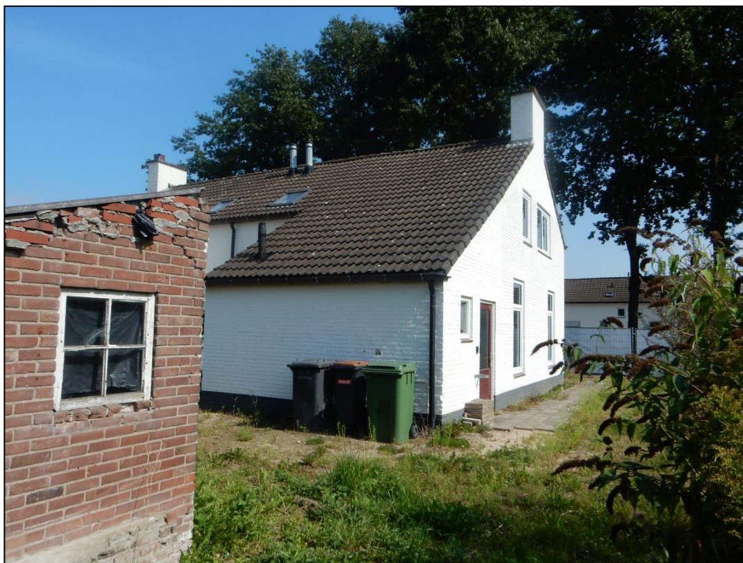
Figuur 1 De woningen (rechts) en schuur (links) op de planlocatie zullen gesaneerd worden.
